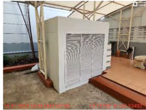
ภาพที่ 2-25 ระบบระบายอากาศออกจากลานจอดรถใต้ดิน
