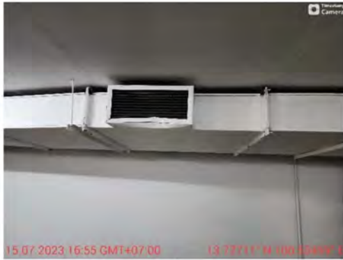
ภาพที่ 2-25 ระบบระบายอากาศออกจากลานจอดรถใต้ดิน
