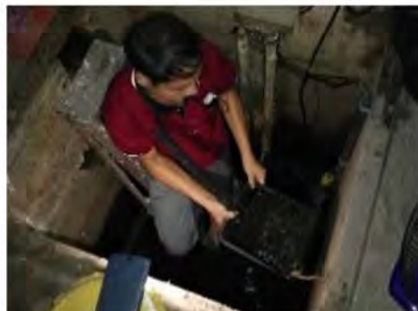
ภาพที่ 2-50 เจ้าหน้าที่ตรวจสอบทำความสะอาดท่อระบายน้ำและบ่อพักน้ำ
